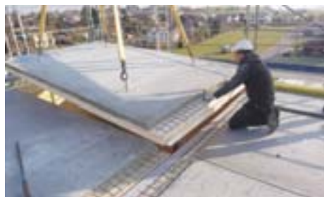
Optiholz forte bei der Montage
